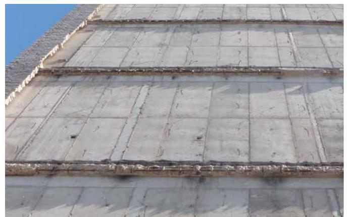
Vormauerschale komplett abgelöst; Drahtanker korrodiert | Facing completely detached; wire anchor corroded
