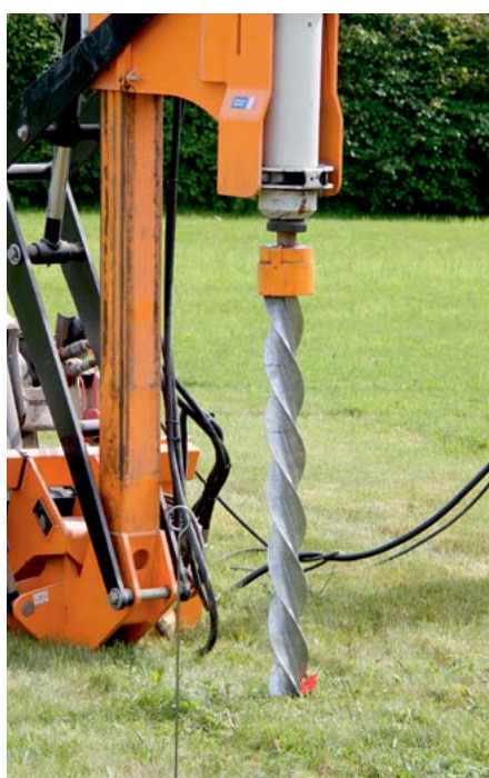
Einrammen der Gewindepfähle Pile-driving
