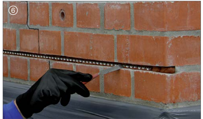
⑥ DESOI Spiralanker in den Spiralankermörtel drücken | Embed the DESOI Spiral Anchor Mortar
