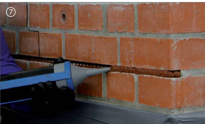
⑦ Zweite Lage DESOI Spiralankermörtel einbringen Insert second layer of DESOI Spiral Anchor Mortar
