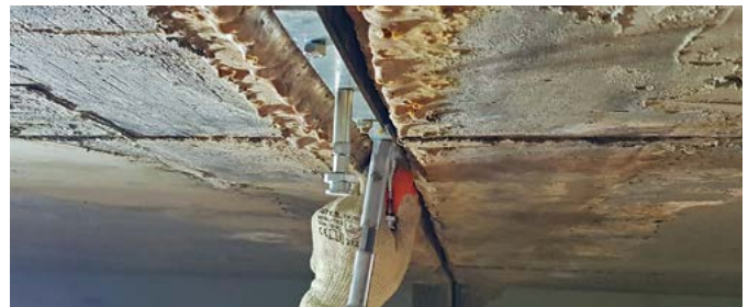
DESOI Quick Seal über das Anzugsrohr spannen | Clamp DESOI Quick Seal over the tightening nut
