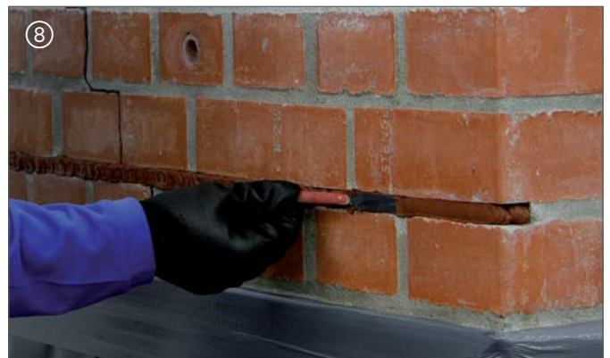
⑧ DESOI Spiralankermörtel glattstreichen | Flatten out the DESOI Spiral Anchor Mortar
