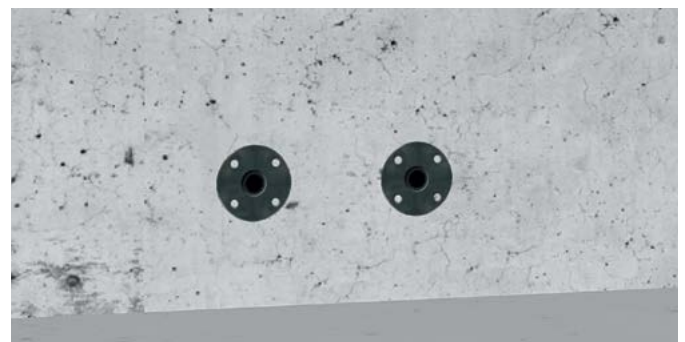
② Nagelpacker nach Entfernen der Schalung ② Nail packers after removal of framework
