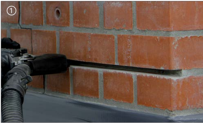
① Fuge mit AS200X Stein- und Fugensäge aussägen Cut the joint / slot by using the AS200X Brick and mortar saw
