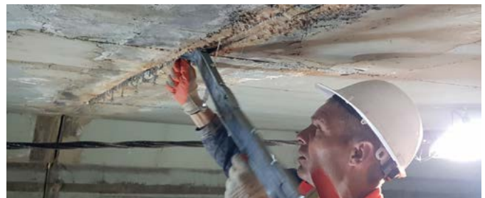
Nach Aushärten des Füllstoffes DESOI Quick Seal einfach entfernen After the filling material has cured, simply remove DESOI Quick Seal
