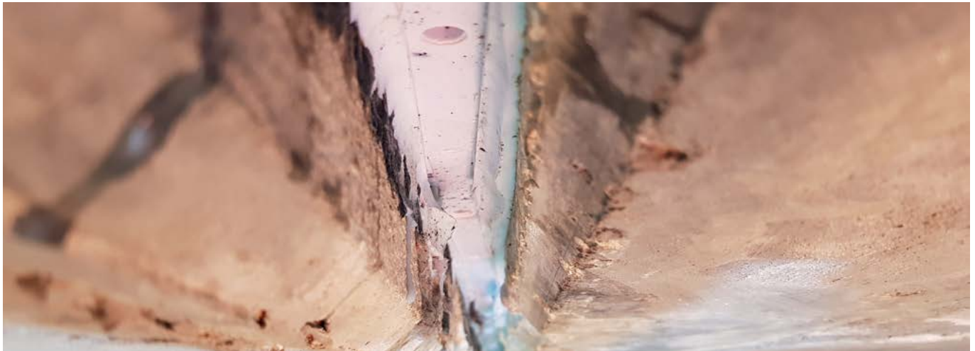
Erfolgreiche Sanierung der Fuge mit dem DESOI Quick Seal und dem Rechteck-Stahlpacker | Successful rehabilitation of the joint with DESOI Quick Seal and the rectangular steel packer
