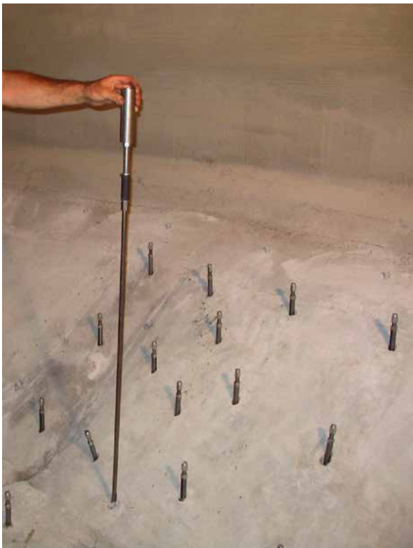
Trinkwasserbehälter „Schwarze Pumpe“
