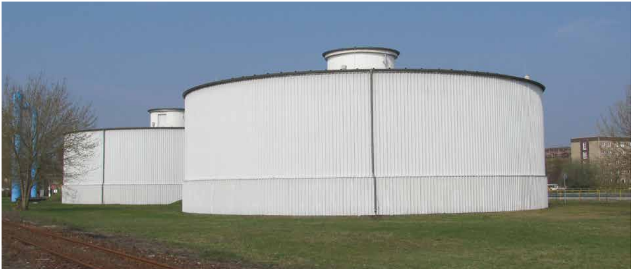
Trinkwasserbehälter „Schwarze Pumpe“
