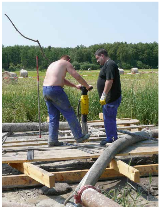
Einbringen der Rammverpresslanzen mit den Rammhammer (Fotos: Desoi)
