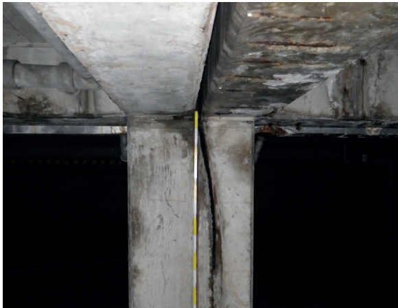
Raumfuge in Unterzug und Stütze
